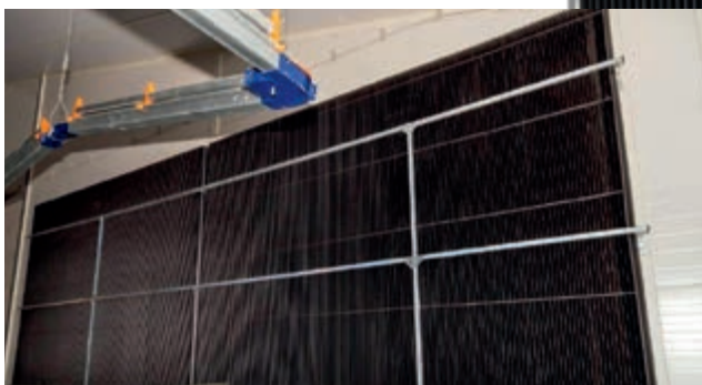
Osłona świetlna w ścianie szczytowej budynku inwentarskiego
