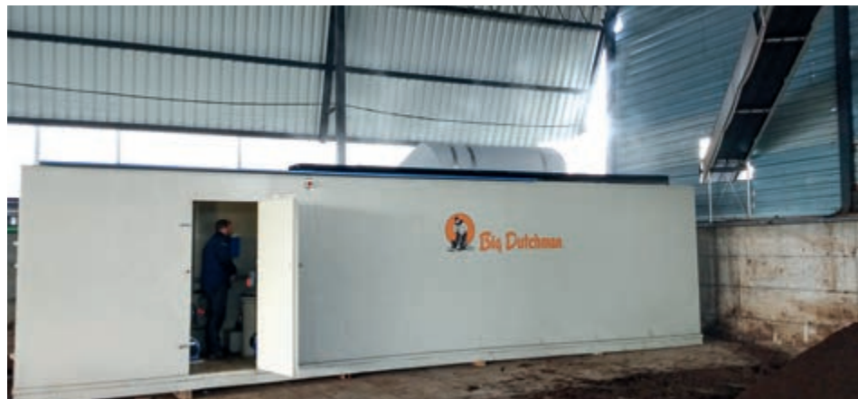
Widok na oczyszczacz powietrza do CompoLiner jako gotowy do podłączenia system
