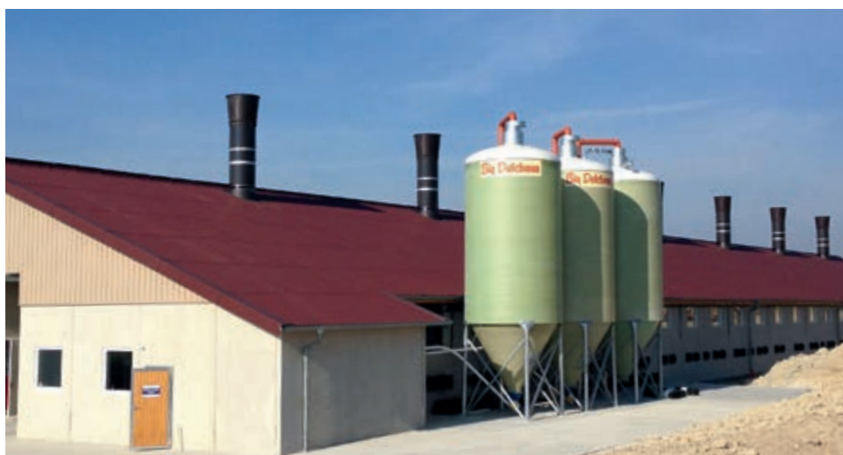
Esempio : uscite d'aria di scarico >3m sopra il colmo
