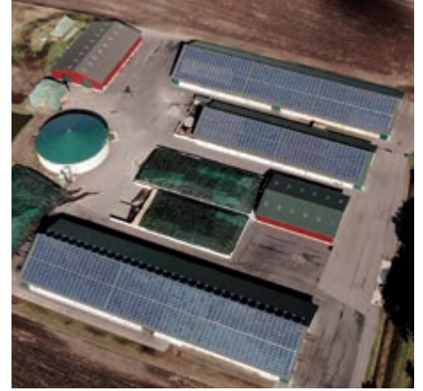
Rendimiento de la instalación: 669,76 kWp
