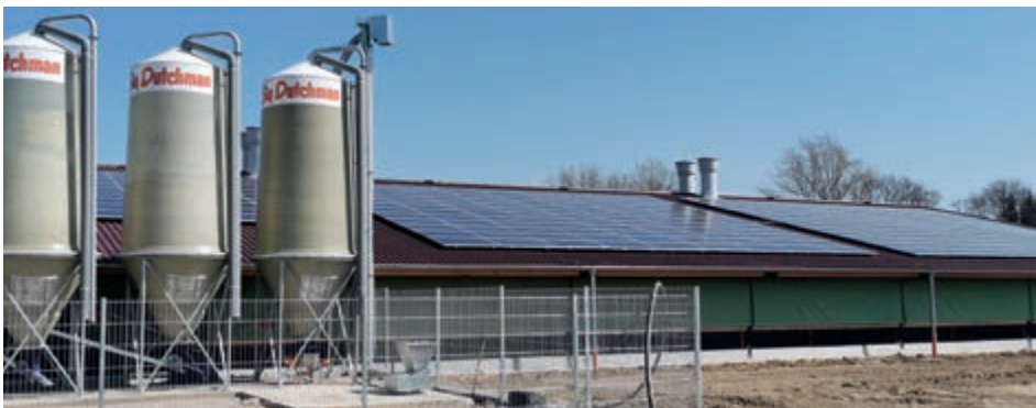
Rendimiento de la instalación: 99 kWp
