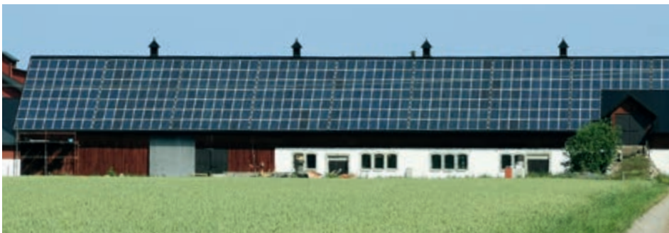
Rendimiento de la instalación: 122 kWp
