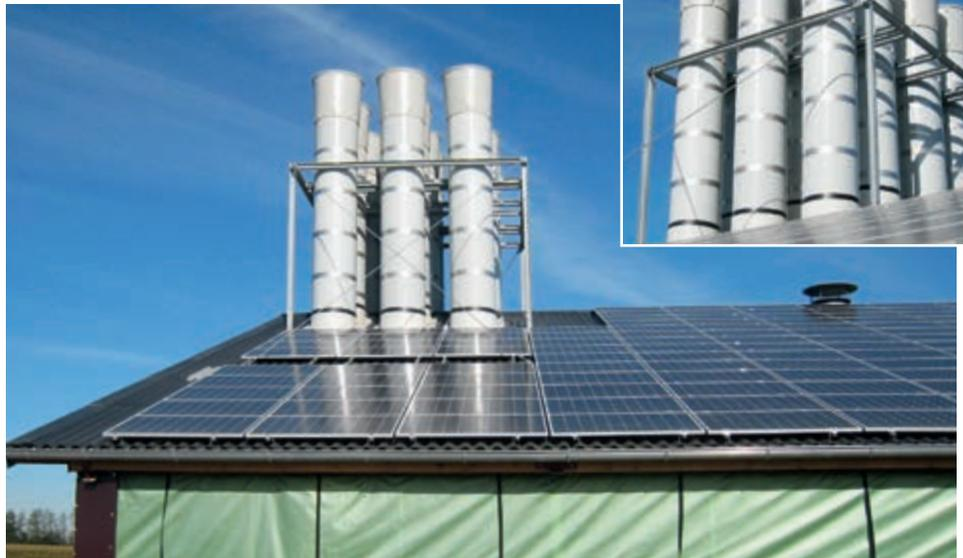
Neben der Möglichkeit, die einzelnen Kamine soweit zu verlängern, bis die erforderliche Höhe erreicht ist, kann auch ein separater Abluftturm an den Stallgiebel gebaut werden. Dies ist eine komfortablere, jedoch etwas auf-
