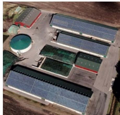
Мощност на инсталацията – 669,76 kWp
