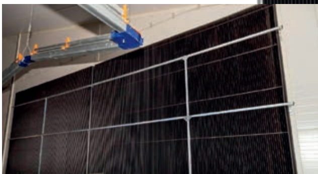
Светлозащитна стена на калкана
