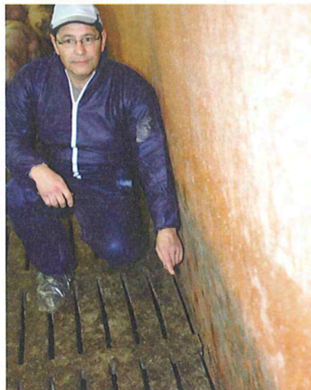
Les caillebotis ont été découpés sous les auges pour éviter l'accumulation de saletés et faciliter le lavage.
